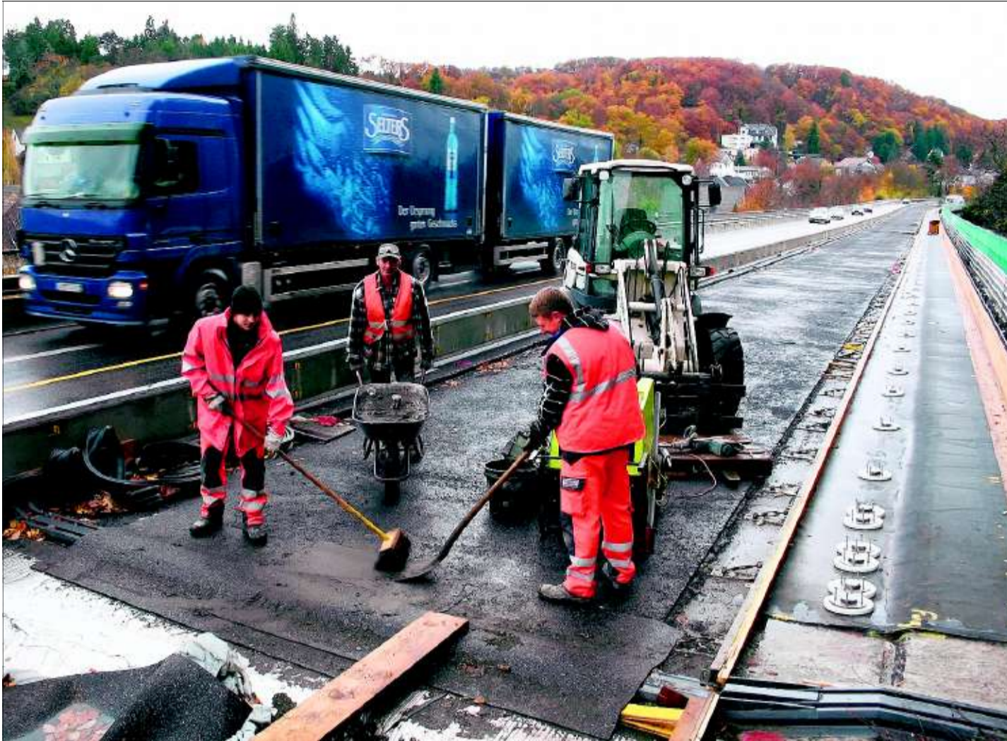
Während rechts auf der B 51-Brücke gearbeitet wird, läuft der Verkehr links in beiden Fahrtrichtungen ohne Probleme. (Foto: Schmitz)
